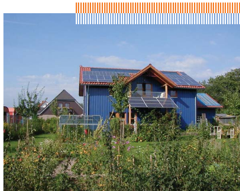
Einfamilienhaus mit Photovoltaikanlage Foto: Dipl.-Ing. Andreas Stemberg, Lage
